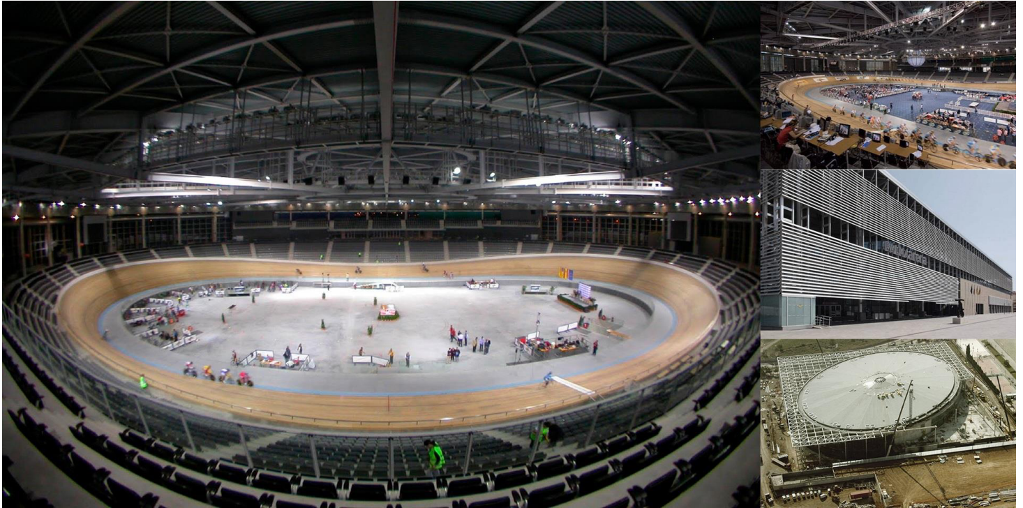
Supervisión de estructura de hormigón y proyecto de construcción de cubierta exterior y fachada
